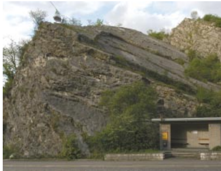
(Links) Felssturz Lägernkopf 1899; (Rechts) Situation Frühling 2003.
