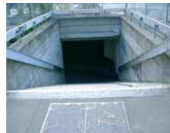
Düstere und steile Treppenunterführung an der Bruggerstrasse
