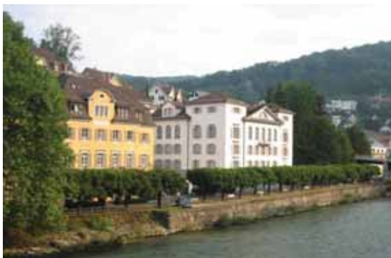
Abb. 6.36 Uferkanzel bei Gebäude Zum Schiff, Freihof Partieller oder kompletter Rückbau denkbar
