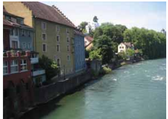
Abb. 6.31 Altstadtsockel mit vorgelagertem Kanal Städtebauliche Klärung durch Rückbau der Ufermauer
