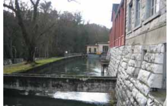
Abb. 6.61 Kraftwerkskanal Oederlin mit Leitbauwerk Entwicklungspotential zur linksufrigen Wegeverbindung
