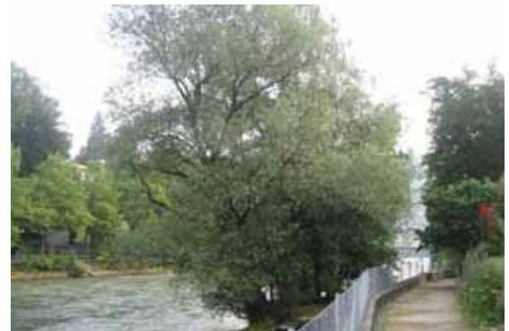
Abb. 6.47 Ehemalige Leitbauwerke Wasserkraft Kulturhistorische Werte bewahren und gleichzeitig ökologische Werte fördern
