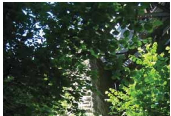
Abb. 6.11 Widerlager Eisenbahnbrücke Verstecktes monumentales Bauwerk
