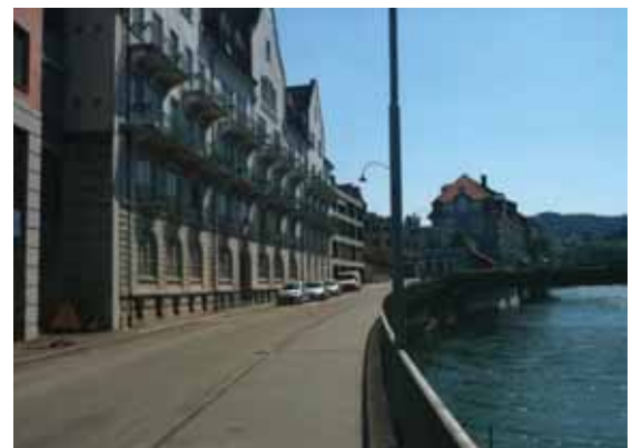
Abb. 6.57 Historische Fassade "Kleine Bäder" Gestalterische Klärung durch Rückbau Fahrbahnauskragung
