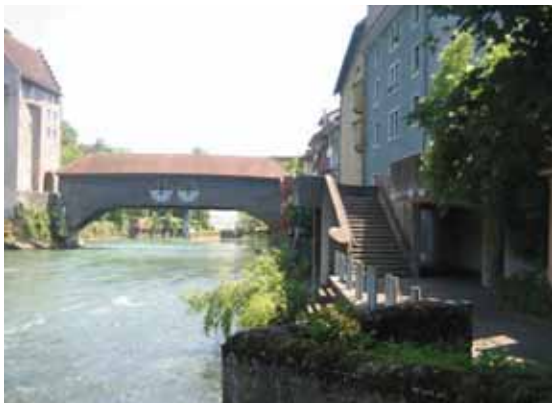
Abb. 6.30 Schlüsselstelle im Limmatraum Ensemble Landvogteischloss, Holzbrücke und Altstadt
