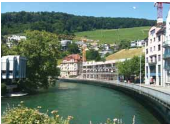
Abb. 6.56 Durchgehende Sockelausbildung Hochwertige Schliessung der Baulücken mit Neubauten
