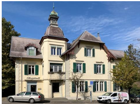
Abbildung 23 Restaurant Oberstadt (Quelle: Stadt Baden, Denkmalwerkstatt, 2023)
