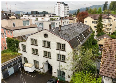
Abbildung 25 Demuth-Halle (Quelle: Stadt Baden, Abteilung Bau, 2023)
