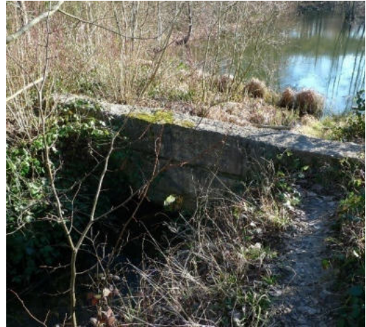
Historisches Bauwerk mit Ablauf in den südlichen Weiher - Bestand 2020
