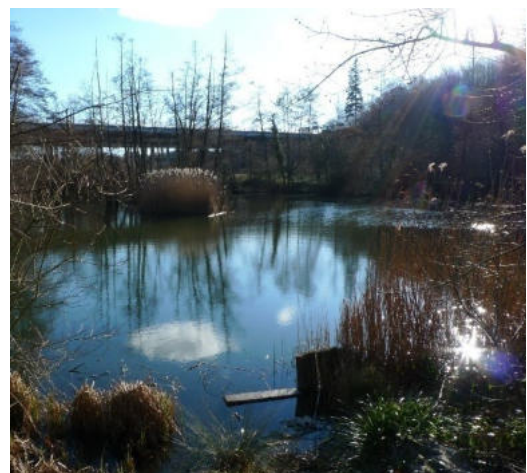
Südlicher Weiher mit Autobahnbrücke im Hintergrund - Bestand 2020
