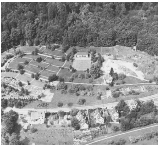
Der 1949 fertiggestellte Friedhofsbereich (linke Bildhälfte) und die Friedhofshalle von Albert Froelich (Bildmitte) - Quelle: Stadtarchiv Baden Q-04-013-02
