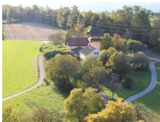
Sicht von Osten vom Wasserturm aus - Bestand 2019
