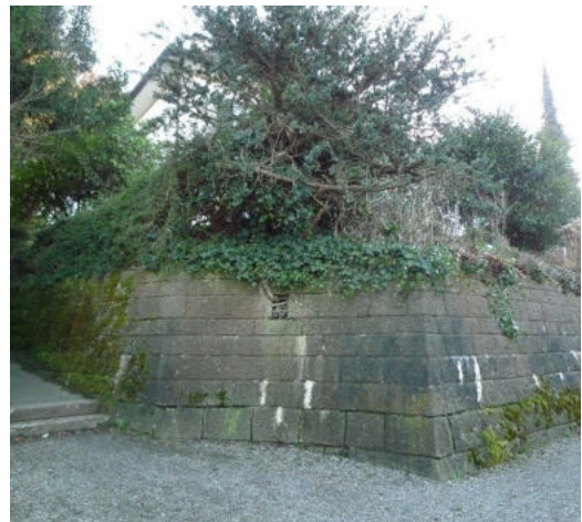
Sicht auf Stützmauern von Norden vom Kiesrondell am Kreuzlibergsteig - Bestand 2020
