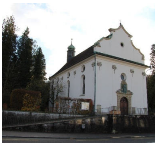
Nordfassade der Wallfahrtskapelle - Bestand 2019
