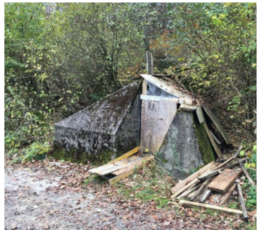
Umnutzung Panzersperre als Hütte - Bestand 2019
