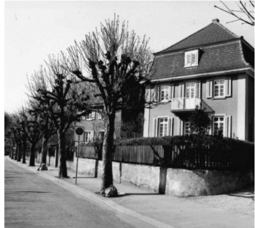
Sicht von Strasse "Im Roggebode" undatiert, eidg. Archiv für Denkmalpflege Bern
