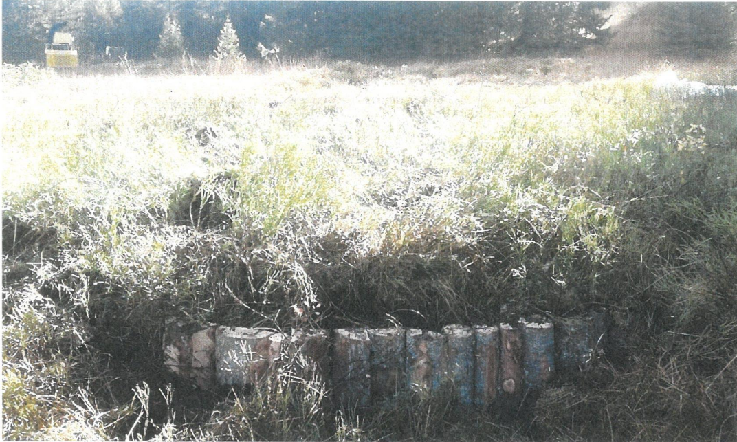
Abbildung 13: Grabenschultern sind oft eingefallen, was bedingt, dass Massnahmen seitlich über die Grabenränder hinaus ins gewachsene Gelände hinein und unter Umständen leicht überhöht erfolgen sollen. Die Abbildung zeigt ein Querprofil eines Grabens in einem Quellmoor mit Grabenschultern, die 4.5 m auseinanderliegen bei einer Grabentiefe von 70 cm.
