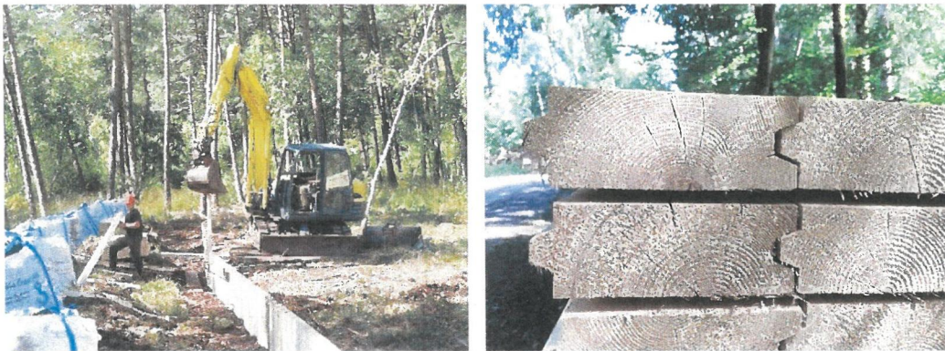
Abbildung 5: Spunden von Holzbrettern in einem Waldmoor im Kanton Zürich (links). Spundwandbretter mit Nut und Feder (rechts)
