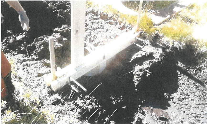
Abbildung 3: Spundwand mit Zangenhölzern an der Oberkante der Spundwandbretter
