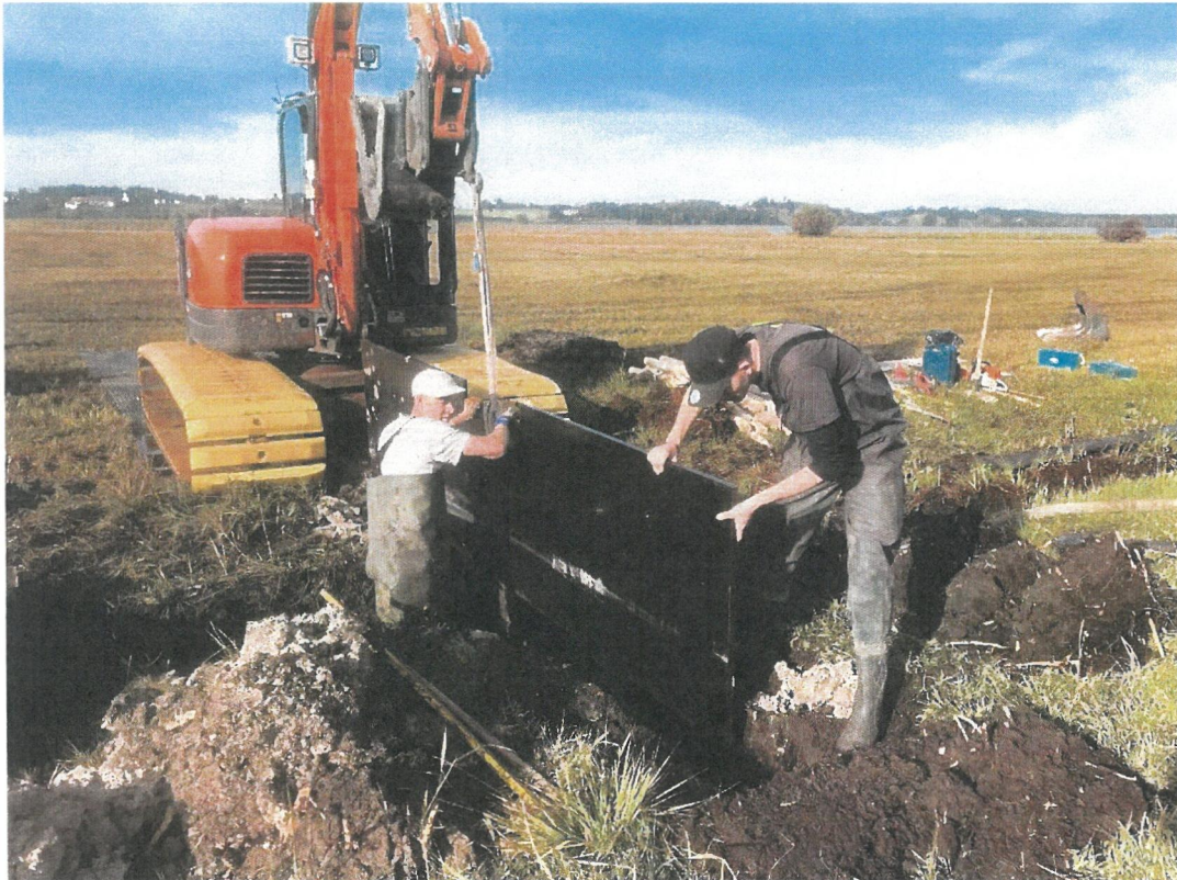
Abbildung 8: Brett mit Führungsleiste, in die die Holzplatte unten eingefügt wird. Dies garantiert, dass Das Brett stabil im Boden verankert ist und nicht absinkt. Eine solche Führungsleiste soll bei Holzplatten mit Überlauf eingebaut werden.
