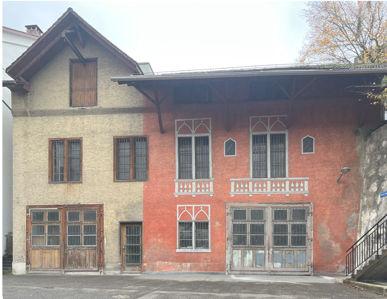
Ostfassade, Kronengasse 37 „Ferrogebäude“
