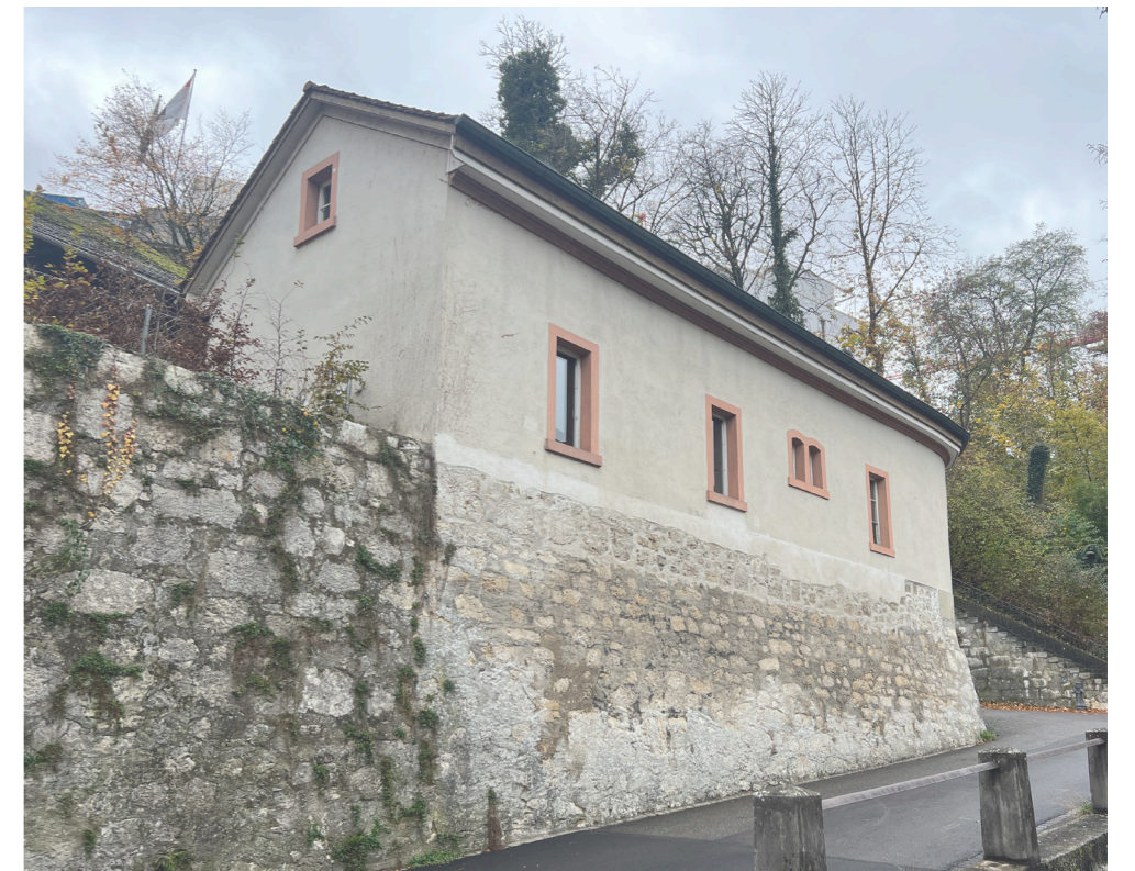
Süd- und Ostfassade, Kronengasse 45 „Rundbau“
