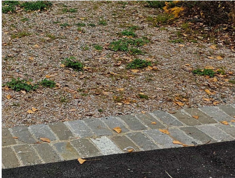
Bundsteinreihe zeichnet die Aussenmauer des Agnesespitals nach
