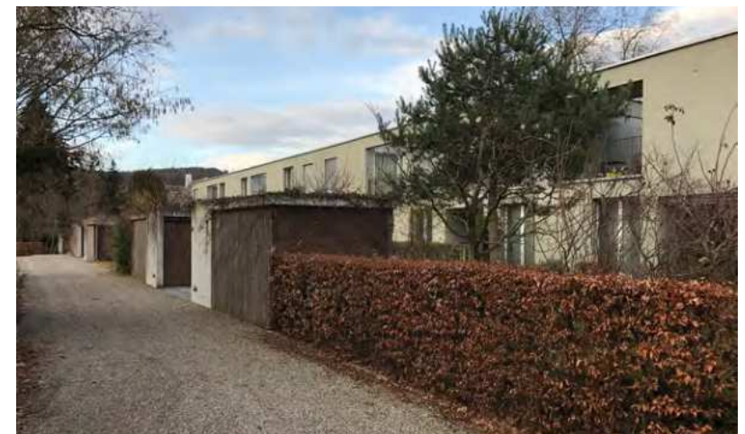
Längszeilenbauten (o.) historisches Langhaus und (u.) MFH - Floraweg (Quelle: vdw)
