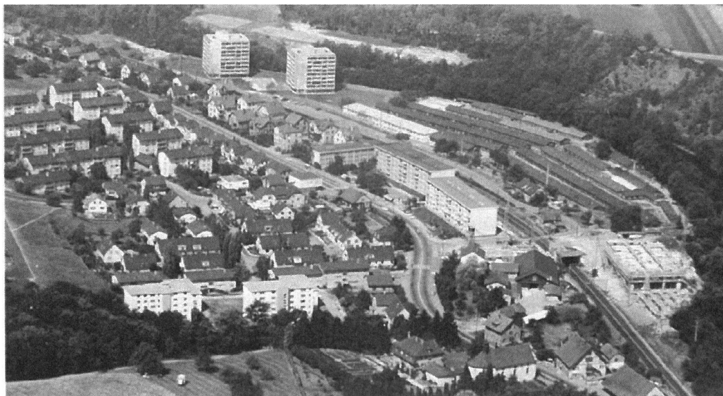
Abbildung 4: Barackensiedlung im Brisgi 1964 (Quelle: Stadt Baden)
