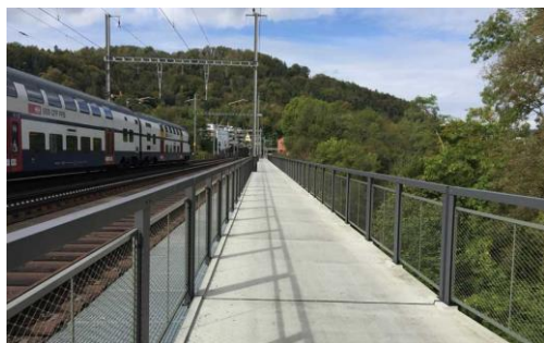
Laufende Optimierung der Veloinfrastruktur: Verbreiterung der Limmatbrücke nach Wettingen
