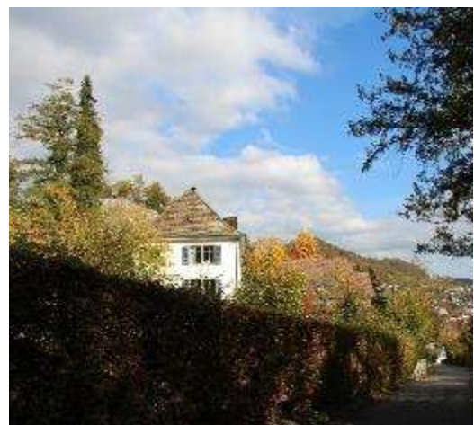
Sicht von Südwesten auf Westfassade der Villa - Bestand 2019
