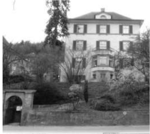
Sicht von Mellingerstrasse auf Nordfassade 1992 - Garteninventar Zulauf + Partner
