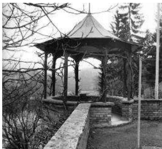
Gartenpavillon undatiert, eidg. Archiv für Denkmalpflege Bern
