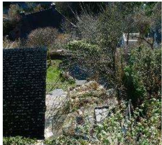
Mosaikplattenbelag, Natursteinstufen und ein Teich sind vor der Stützmauer ersichtlich - Bestand 2020
