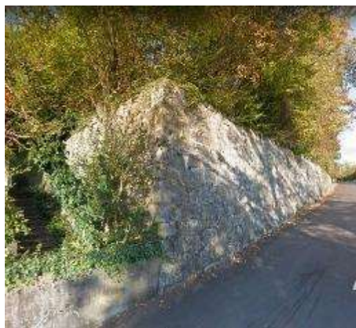
Sicht von Burghaldenstrasse auf Stützmauer mit Treppe links im Bild - Google Street View 2020
