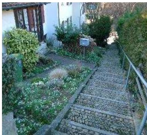
Treppenanlage mit schöner Natursteinpflasterung - Bestand 2020
