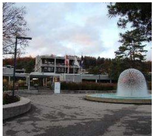
Sicht von Südosten auf Eingangspartie mit Brunnen - Bestand 2019
