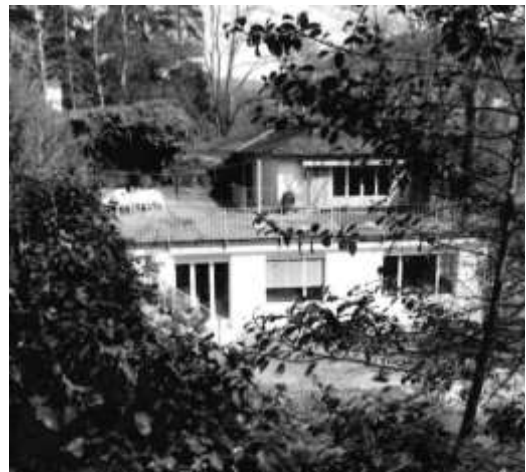
Links im Bild die Stützmauer, rechts der untere Gartenteil 1992 - Garteninventar Zulauf + Partner
