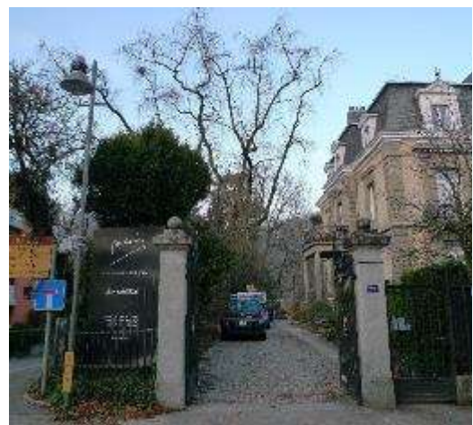
Sicht von Römerstrasse auf Eingangsportal - Bestand 2016
