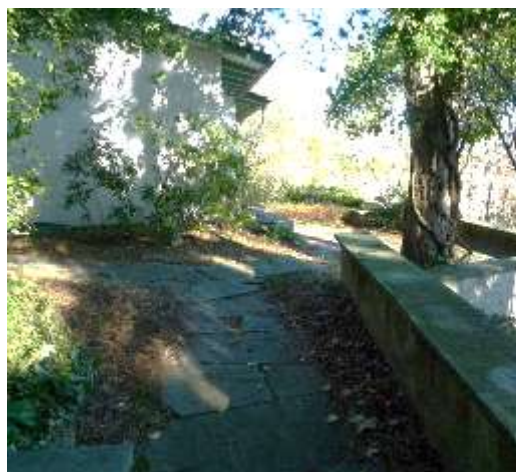
Platz mit Mosaikplatten und Betonmauer mit Natursteinkrone an der Westseite des Hauses - Bestand 2020
