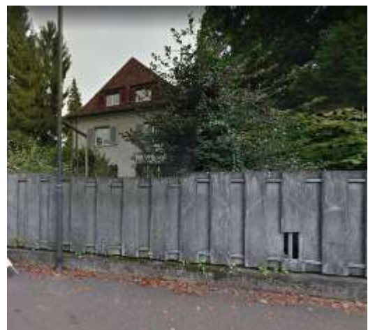
Sicht vom Ländliweg mit Eternit-Lamellen - Google Street View 2020
