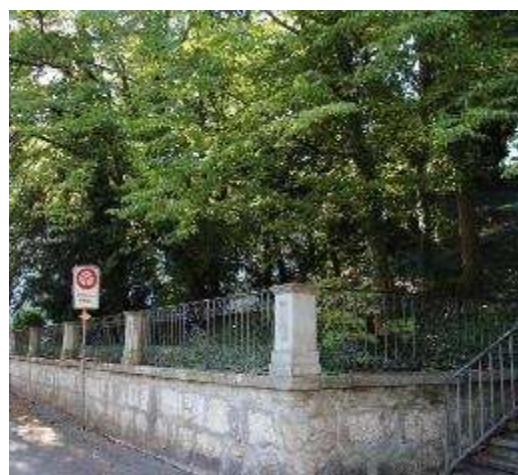
Stützmauer mit Gartenzaun und Steinpfosten entlang der Limmatpromenade - Bestand 2019
