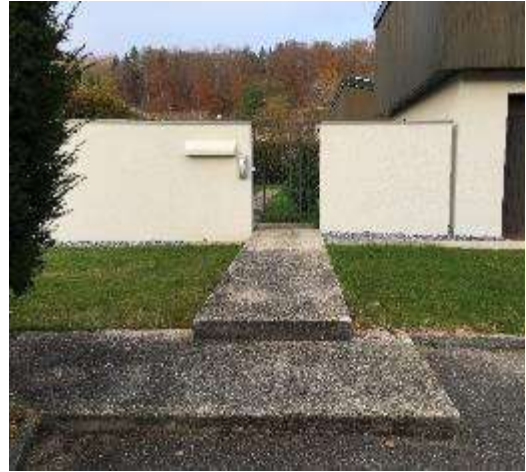
Sicht von Südwesten - Bestand 2019
