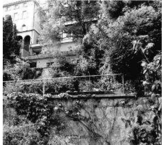
Sicht von der Limmatpromenade auf Stützmauer 1992 - Garteninventar Zulauf + Partner
