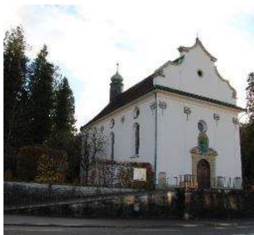
Nordfassade der Wallfahrtskapelle - Bestand 2019
