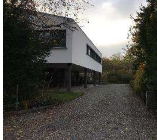
Sicht vom Föhrenweg auf die chaussierte Einfahrt - Bestand 2019
