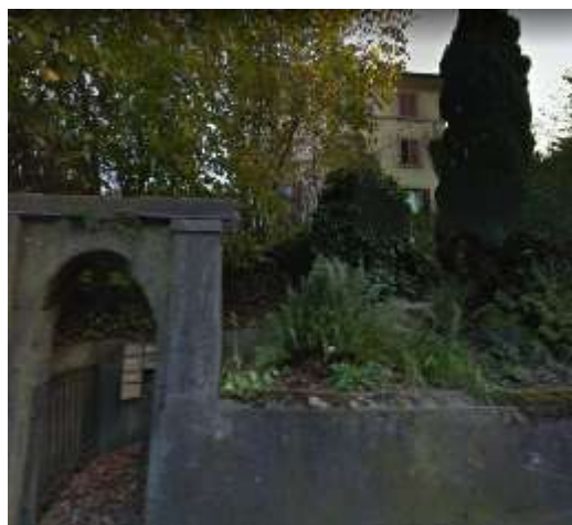
Sicht von Mellingerstrasse auf Stützmauer mit Portal - Google Street View 2020
