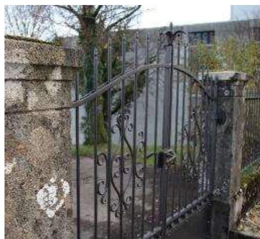
Schmiedeeisernes Eingangstor im Osten - Bestand 2019
