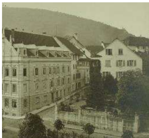
Blick von Norden auf den von einer Stützmauer eingefassten Garten, undatiert - Stadtarchiv Baden
