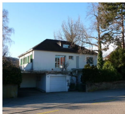
Sicht von der Seminarstrasse auf den Vorgarten mit Garage - Bestand 2020
