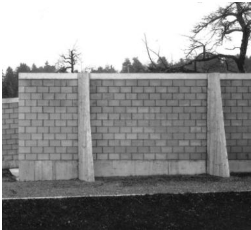
Entlang der Zufahrtstrasse schliesst eine Mauer aus grauen Kalksandsteinen ab - aus: Kienast 2002, S. 252
