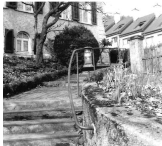
Treppenanlage zum Haus 1992 - Garteninventar Zulauf + Partner
