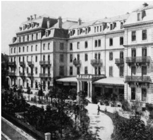
Grand Hotel undatiert, eidg. Archiv für Denkmalpflege Bern
