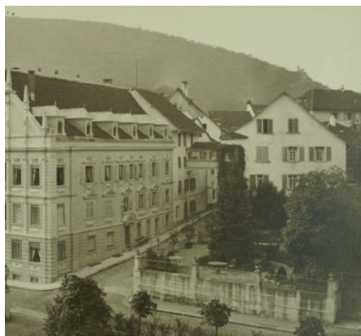
Blick von Norden auf den von einer Stützmauer eingefassten Garten, undatiert - Stadtarchiv Baden
