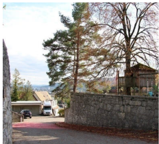
Sicht von Nordosten auf Stützmauer entlang der Burghaldenstrasse - Bestand 2019
