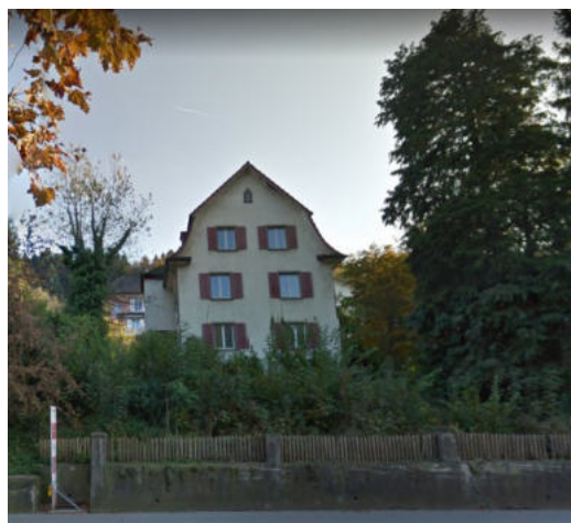
Sicht von Mellingerstrasse auf Stützmauer und Villa - Google Street View 2020
