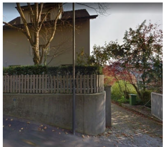
Sicht von Norden auf Eingangssituation mit Tor und Pflasterung - Google Street View 2020
