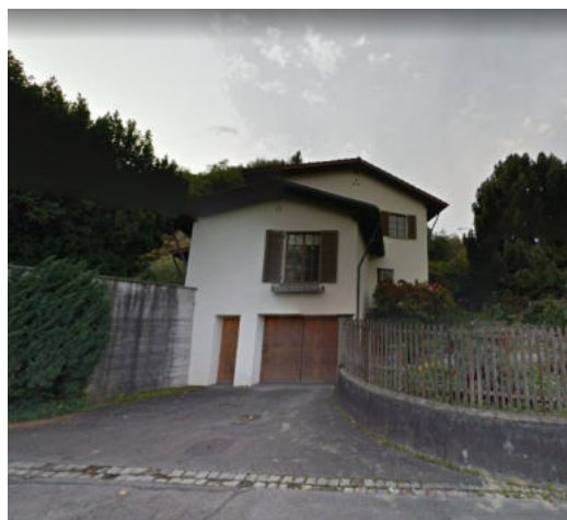
Sicht vom Ländliweg von Osten mit Stützmauer - Google Street View 2020
