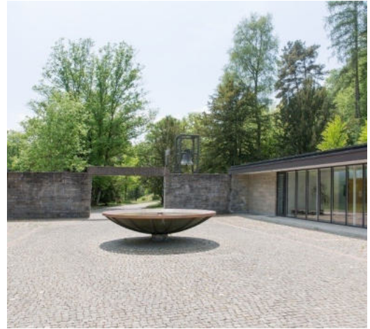
Im Zentrum des Hofes steht eine Brunnenschale aus Kupfer - Bestand 2018
