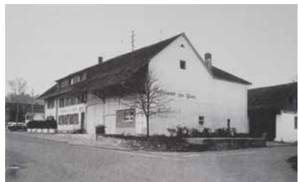
Zustand 1960er-Jahre mit altem Wirtschaftsgebäude
