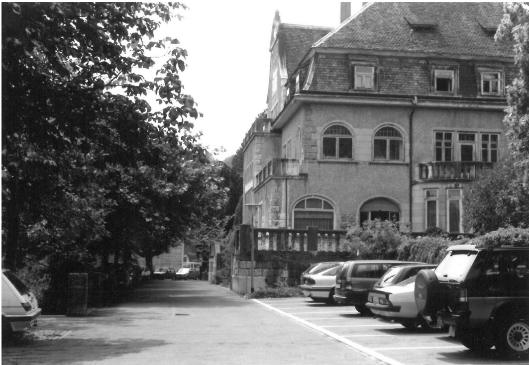
Oberste Terrasse - Bestand 1992
