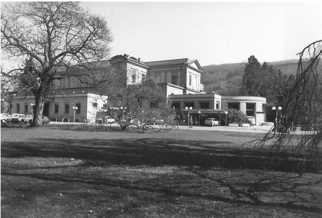
Partie vor dem Casino – Bestand 1992
