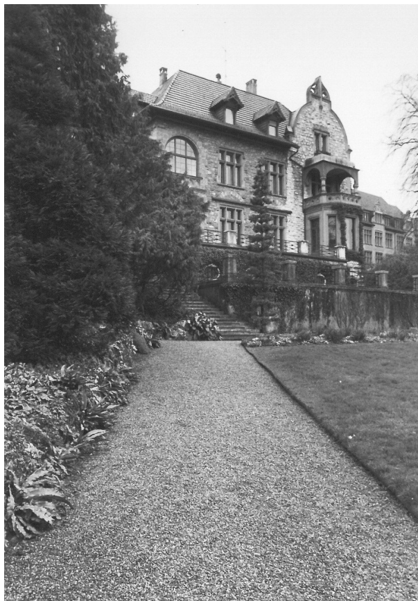
Sicht auf die Villa – Bestand 1992
