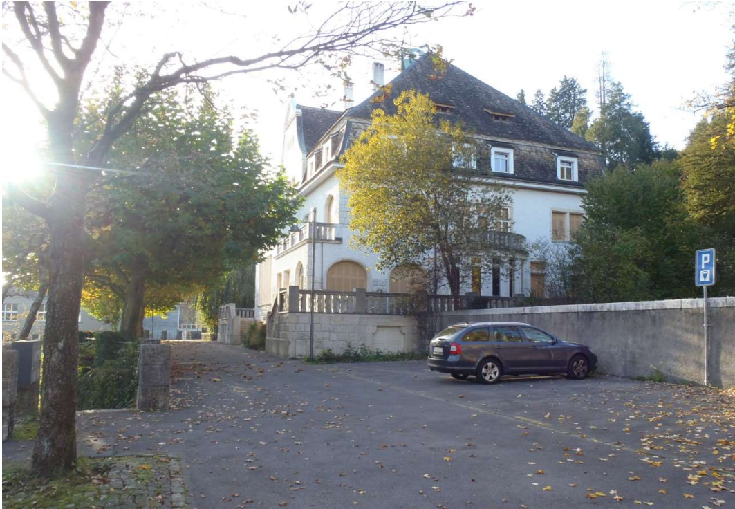
Oberste Terrasse - Bestand 2012
