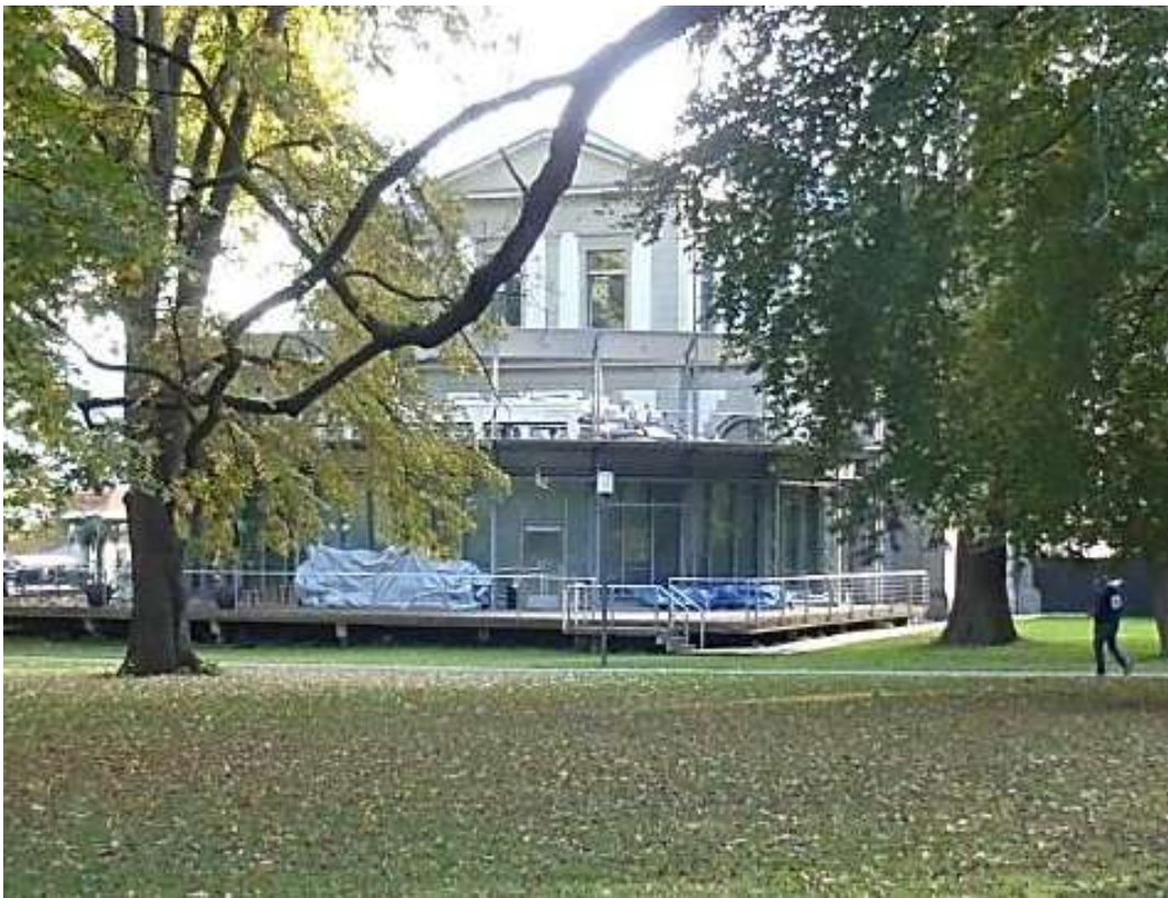
Seitenansicht Casino – Bestand 2012
