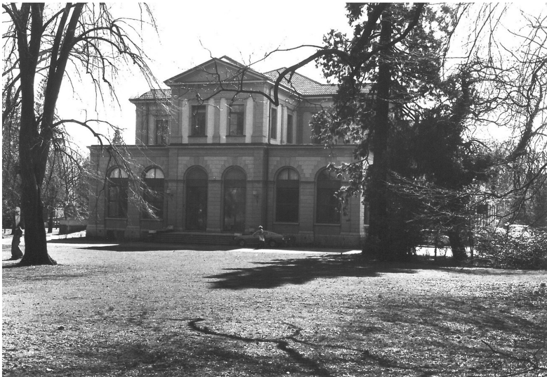
Seitenansicht Casino – Bestand 1992
