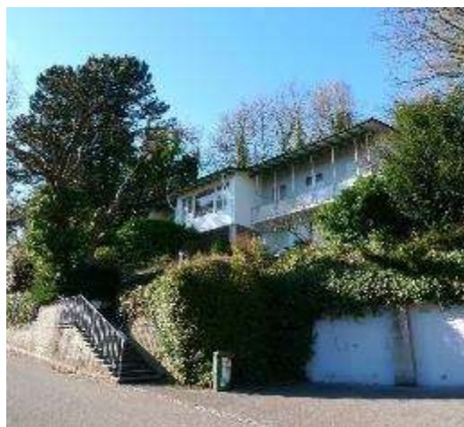
Sicht vom Mühlbergweg auf Haus mit Treppenanlage und Garagen - Bestand 2020
