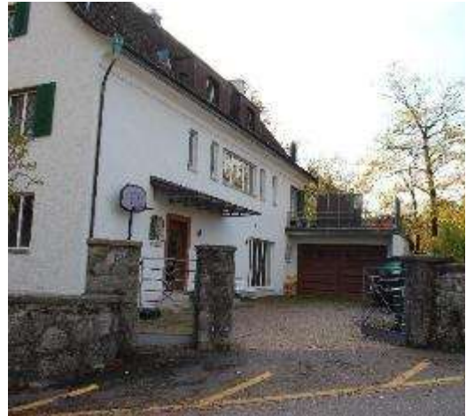
Eingangssituation mit Tor und Natursteinpflasterung - Bestand 2019
