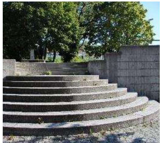
Treppenanlage zur Kantonsschule bei Kreuzung Wettingerstrasse und Seminarstrasse - Bestand 2019
