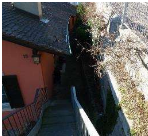
Eine neue Treppenanlage führt zum Eingangsbereich mit Mosaikplattenbelag hinunter - Bestand 2020
