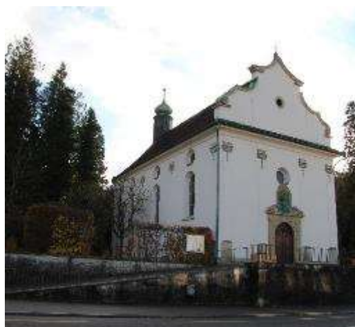
Nordfassade der Wallfahrtskapelle - Bestand 2019
