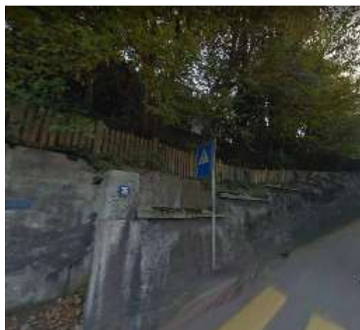
Sicht auf Stützmauer zur Mellingerstrasse, davor verläuft der Kreuzlibergsteig
