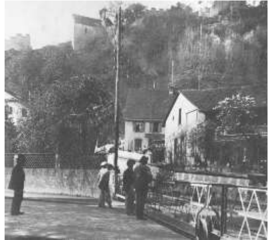
Schiebebarriere an der Bruggerstrasse, oben rechts die Ruine Stein - aus: Badener Tagblatt: Baden um die Jahrhundertwende
