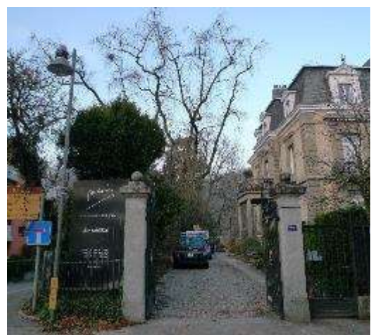
Sicht von Römerstrasse auf Eingangsportal - Bestand 2016
