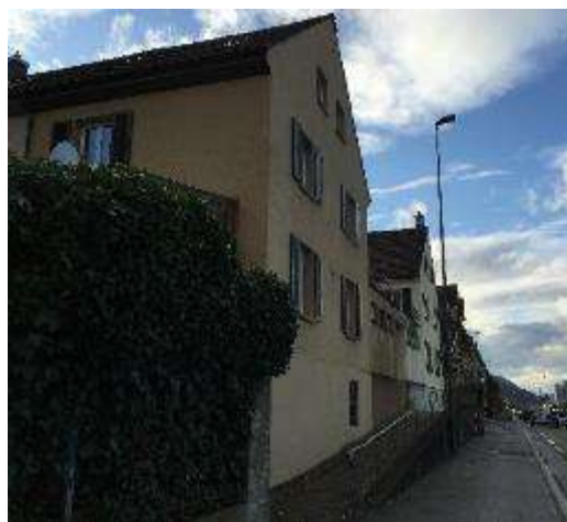
Nordfassade Bruggerstrasse 111/113 mit Rampe und altem Geländer - Bestand 2019
