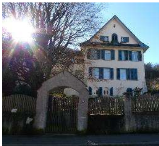
Sicht von der Martinsbergstrasse aus auf das Gartenportal - Bestand 2020
