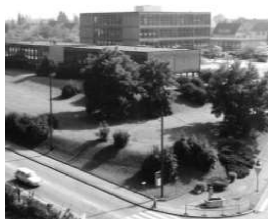
Sicht von Kreuzung Seminarstrasse-Wettingerstrasse, undatiert - Roger Kaysel, Fotograf aus Birmenstorf
