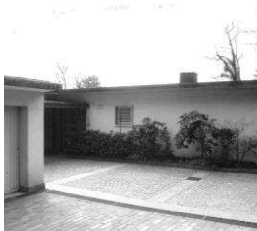
Vorplatz im Norden von Ländliweg 9a mit Garage links im Bild 1992 - Garteninventar Zulauf + Partner
