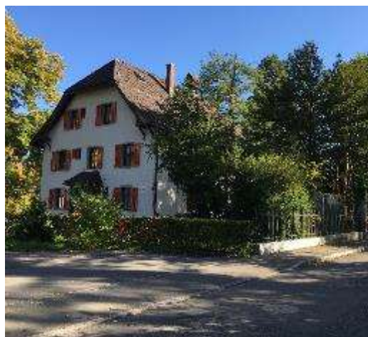
Sicht von Nordosten von Wiesenstrasse - Bestand 2019
