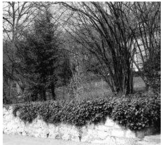
Stützmauer 1992 - Garteninventar Zulauf + Partner
