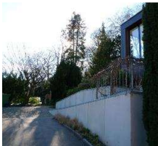
Einfahrt mit Anbau rechts im Bild - Bestand 2020
