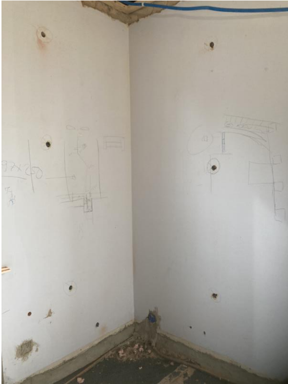
Vorbereitung: Bohrung der Einblaslöcher \text{\O} 35\text{mm}
