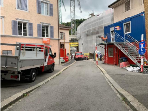
Anhang 7: Schmale Fahrbahn (Bild: Eigene Aufnahme)
