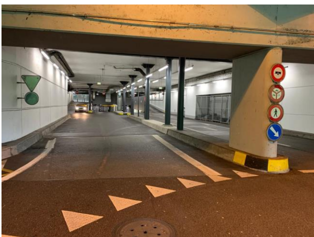
Anhang 5: Niedrige Höhe der Tiefgarage (Bild: Eigene Aufnahme)
