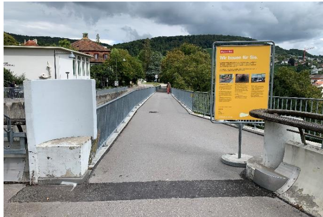
Anhang 2: Engstelle entlang der Fußgängerrampe (Bild: Eigene Aufnahme)
