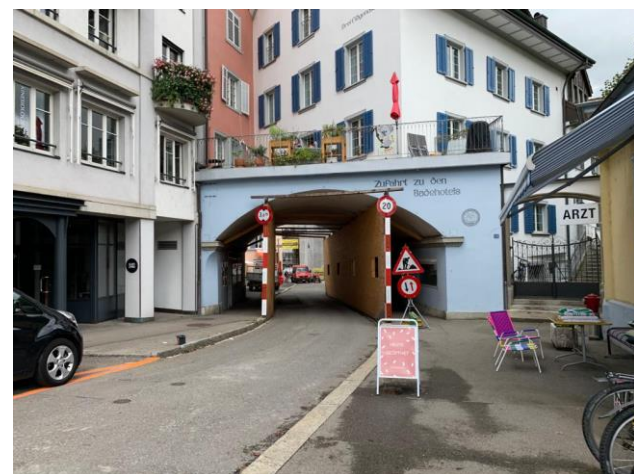
Anhang 6: Hausdurchfahrt und schmale Fahrbahn (Bild: Eigene Aufnahme)
