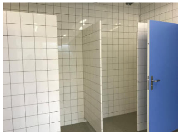
Doppelhalle Kappelerhof, Duschanlage
