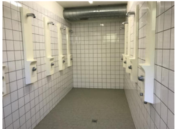
Einzelhalle Meierhof, Duschanlage
