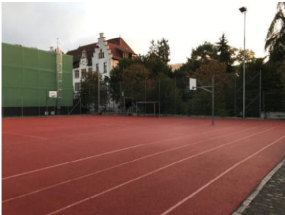
Aussenanlage Ländli, roter Platz
