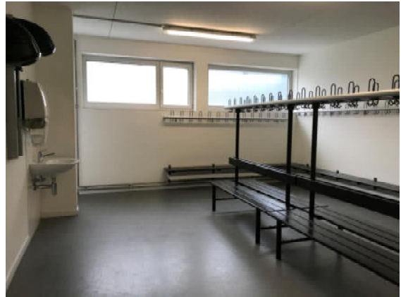
Einzelhalle 5 Garderobe, Kantonsschule (Provisorium)
