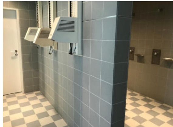
Einzelhalle Höchi, Dättwil, Duschanlage
