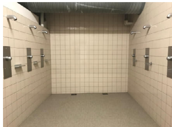
Sporthalle Aue, Duschanlage
