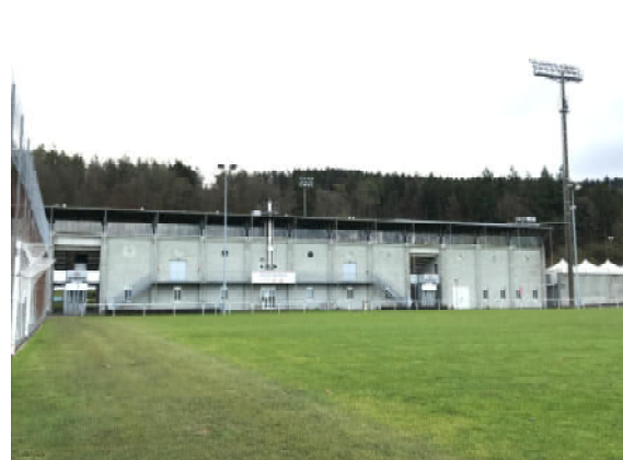
Fussballanlage Esp, Stadiongebäude von aussen
