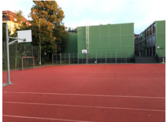
Aussenanlage Ländli, roter Platz
