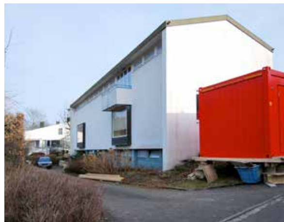
Zustand bei Beginn der Sanierungsarbeiten 2009
